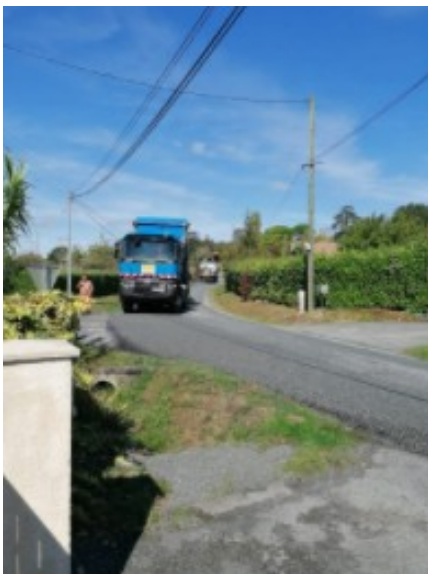
Réfection Chemin des Condats
