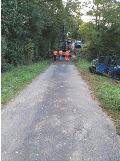
Réfection Chemin des Escrives
