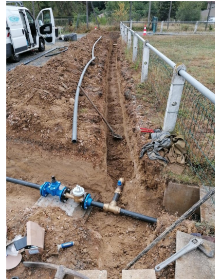
Amélioration du système d'arrosage du terrain de football
