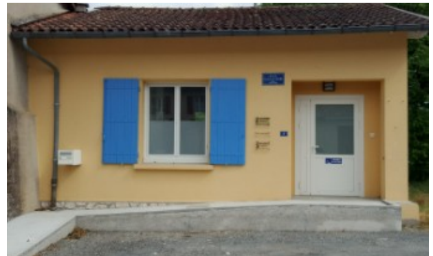
Construction d'une rampe d'accès pour personnes handicapées au cabinet d'infirmières
