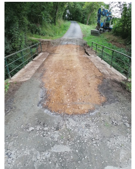
Réfection de chaussée Pont des Escrives
