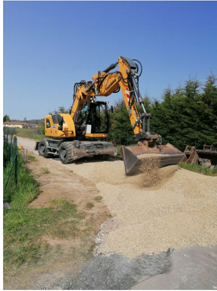
Création d'un chemin d'accès Chemin des Tourterelles
